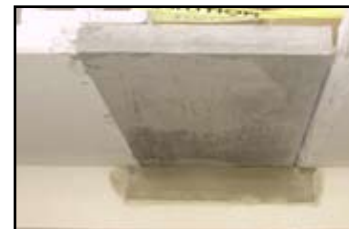
Sikacrete 211 SCC Plus for form and pour on a balcony.
